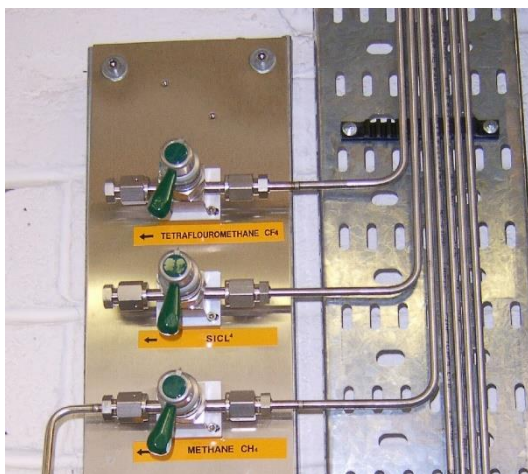
Рисунок 12 Клапана точки забора на газовых линиях
